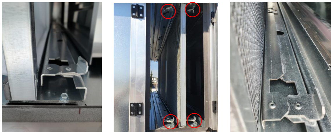
Obr. 1: Systém uchycení filtrů ve filtrační komoře
